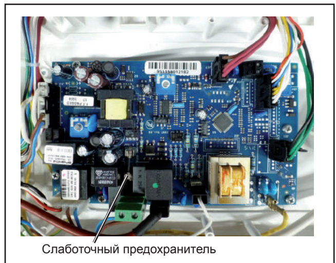
Рис. Замена предохранителей
